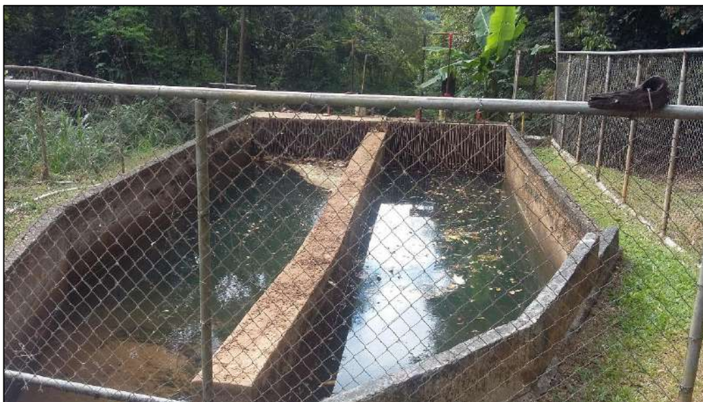
Foto No. 21. Tina de decantación, utilizada para reducir los sedimentos hacia la Mini Hidroeléctrica El Salto
