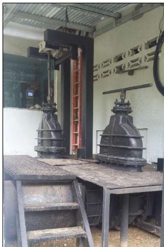
Foto No. 8. Llaves hidráulicas, que permiten el control del caudal o El volumen hídrico
