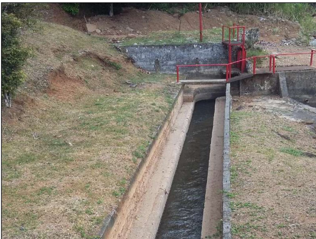
Foto No. 20. Línea de captación de agua hacia la Mini Hidroeléctrica El Salto, con cubierta con especies de tipo rastrojo para el control de la erosión.
