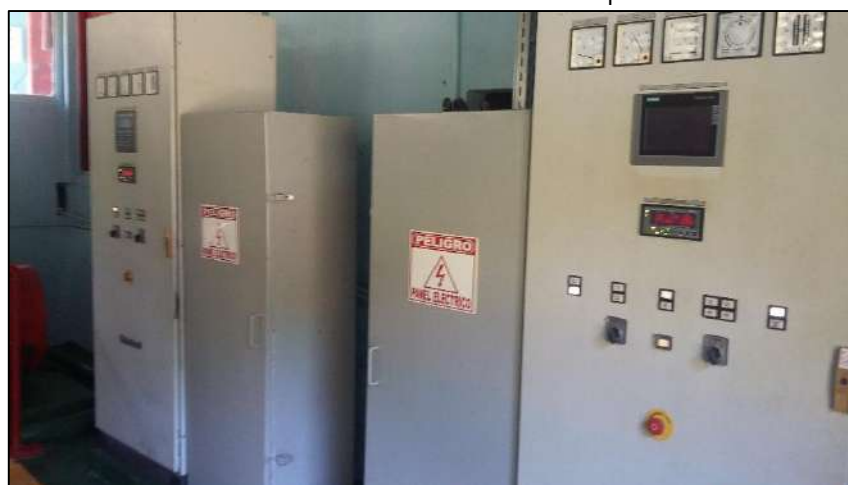
Foto No. 5. Panel de control que permite la generación eléctrica.
