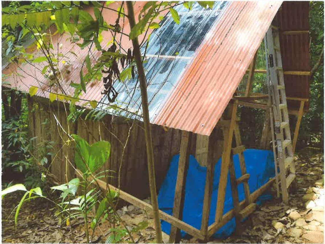
Labores de mantenimiento, cambio de techo una cabaña
