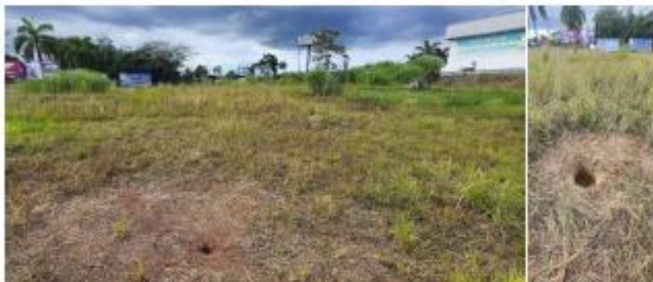
Figura 7.- Vista del área a intervenir, donde se nota las perforaciones realizadas para el estudio de suelos.
