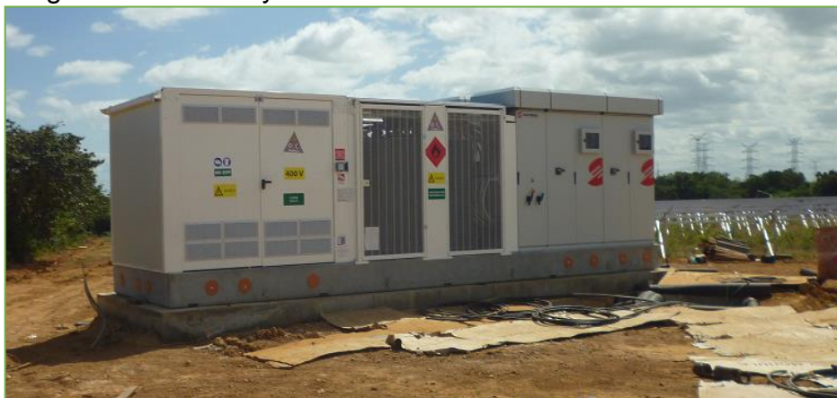
Imagen 4.8 Inversor y transformador
