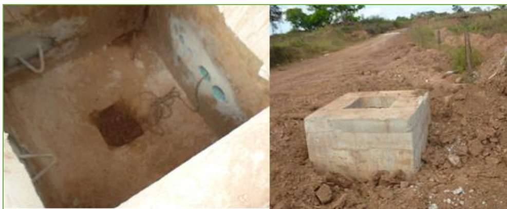
Imagen 4.30 Arqueta de conexión de cables
