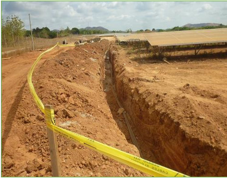
Imagen 4.24 Zanja para cableado (Fuente: Promotor)
