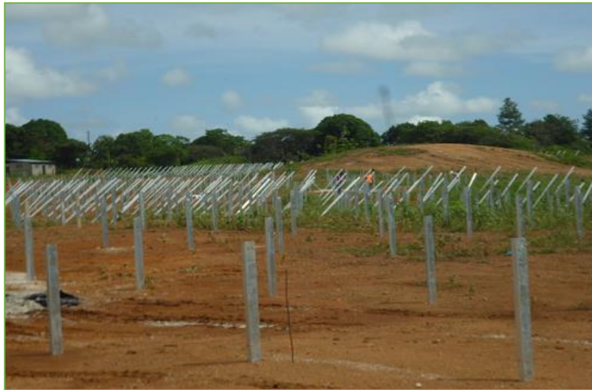
Imagen 4.6 Estructura metálica portadora de los paneles
