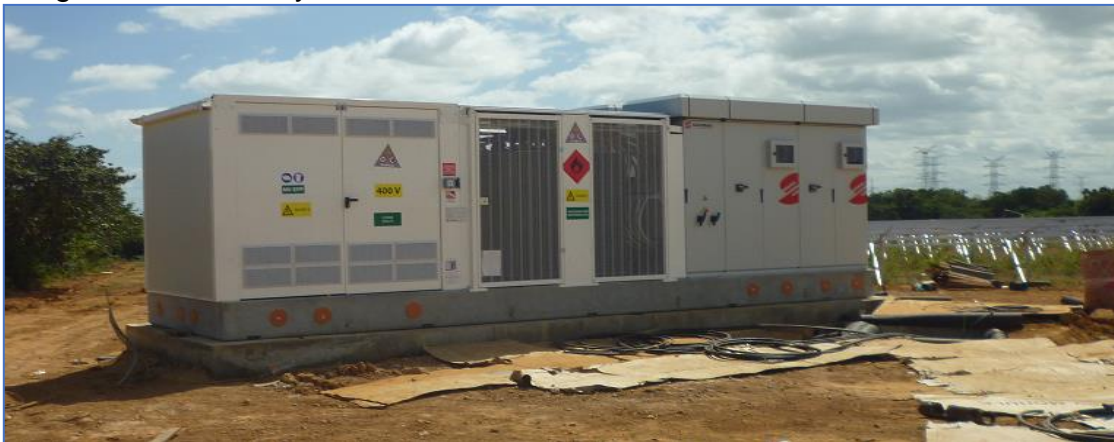
Imagen 4.9 Inversor y transformador
