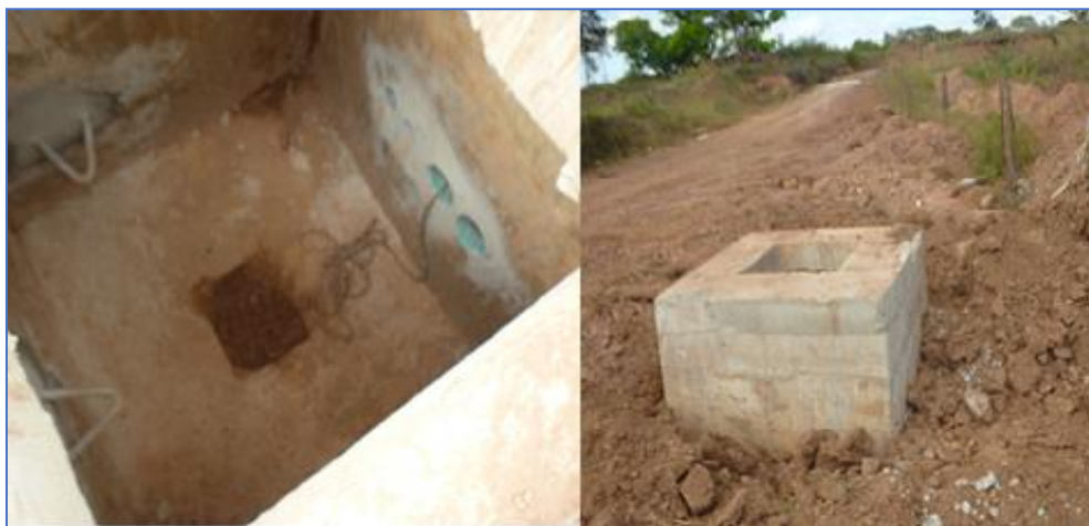
Imagen 4.30 Arqueta de conexión de cables
