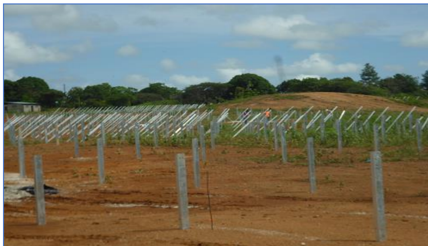
Imagen 4.5 Vista de los postes rígidos de acero galvanizado
