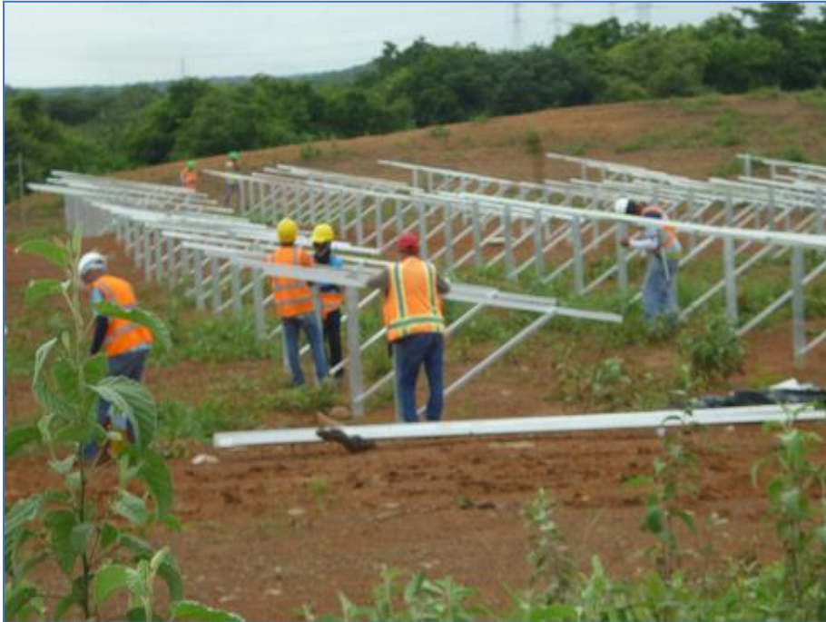
Imagen 4.7 Estructura metálica portadora de los paneles
