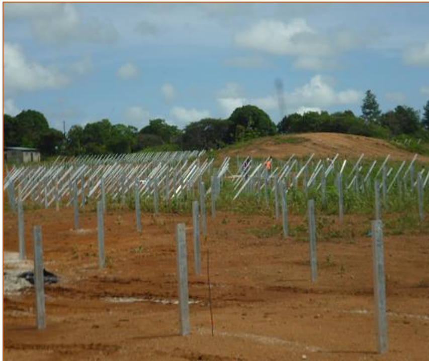
Imagen 4.5 Vista de los postes rígidos de acero galvanizado
