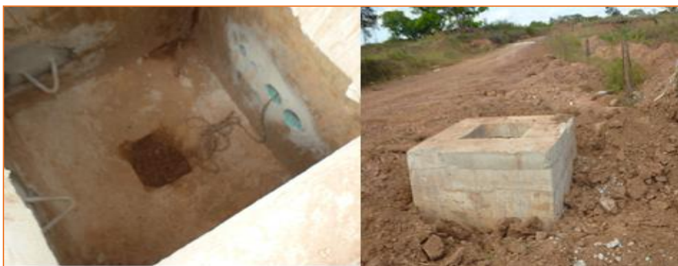
Imagen 4.30 Arqueta de conexión de cables
