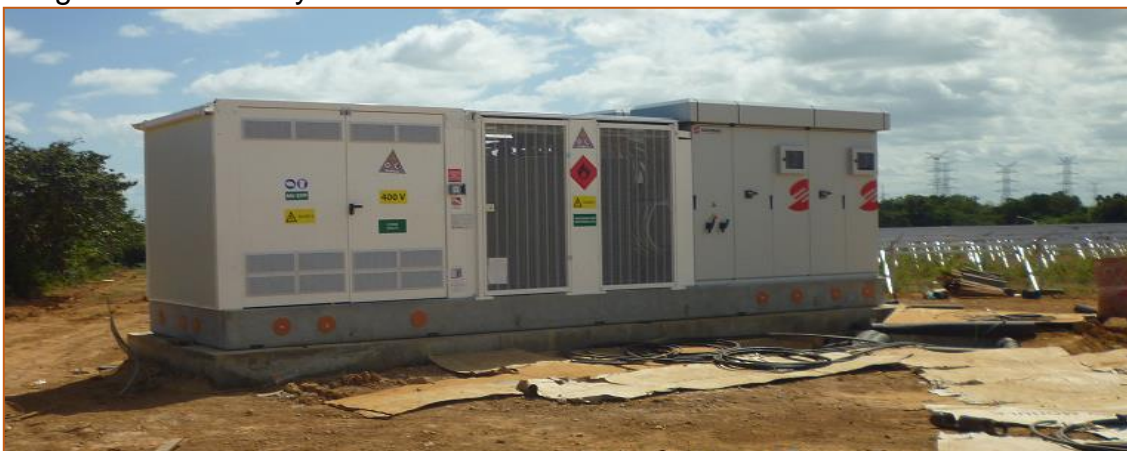
Imagen 4.9 Inversor y transformador
