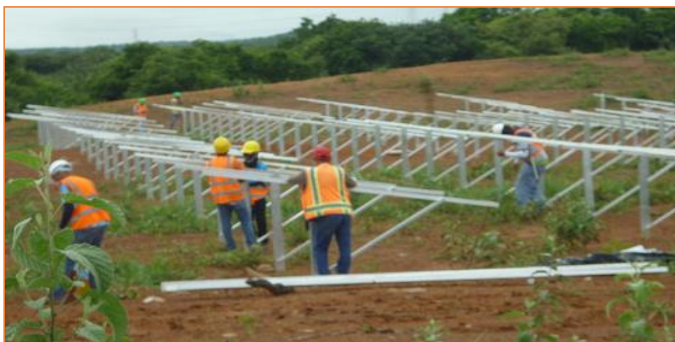
Imagen 4.29 Montaje de estructuras
