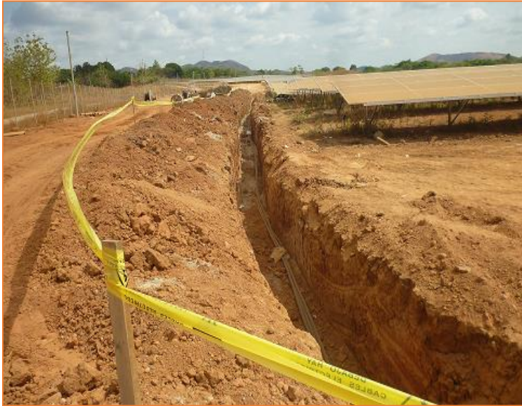
Imagen 4.26 Zanja para cableado (Fuente: Promotor)
