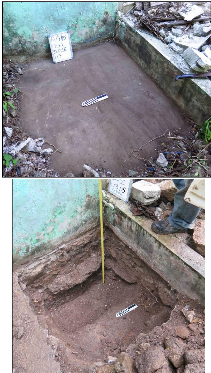
Excavación de la unidad 3. A la izquierda, el inicio. A la derecha, el final de la excavación, nótese la zapata del muro de calicanto oriental.
