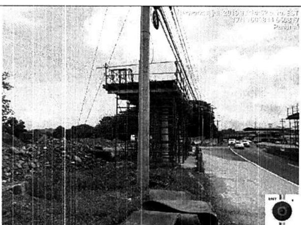
**Fig. 8** La imagen muestra el otro extremo correspondiente al Retorno Vehicular donde observamos que ya se instalaron las columnas de soporte del mismo.
