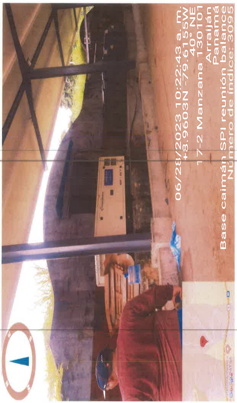
Área de remodelación para el almacenamiento e incineración de Narcóticos se observa el uso de generadores eléctricos sin medidas de contención ni monitoreo de emisión de gases
