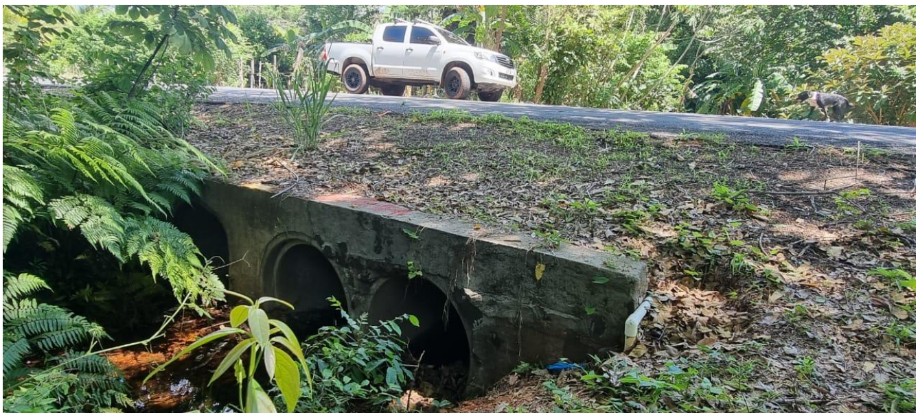
Cruce quebrada Corozal debajo de la vía construida.
