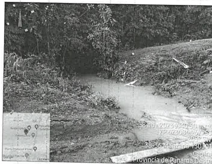
**Imagen 1 y 2.** El sitio donde se realizará la obra en cauce, mantiene el suelo arcilloso y limoso, comprende una topografía plana a inclinada. La obra se construirá sobre la quebrada El Pueblo, la cual atraviesa ambas propiedades. Este cuerpo de agua, al momento de la inspección, mantenía coloración marrón, con un buen caudal.
