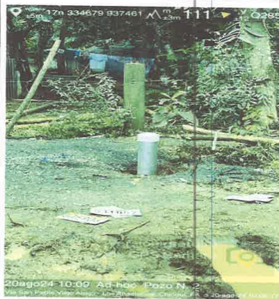
Vista del pozo N°2 con sello sanitario. Fuente: SSHCH
