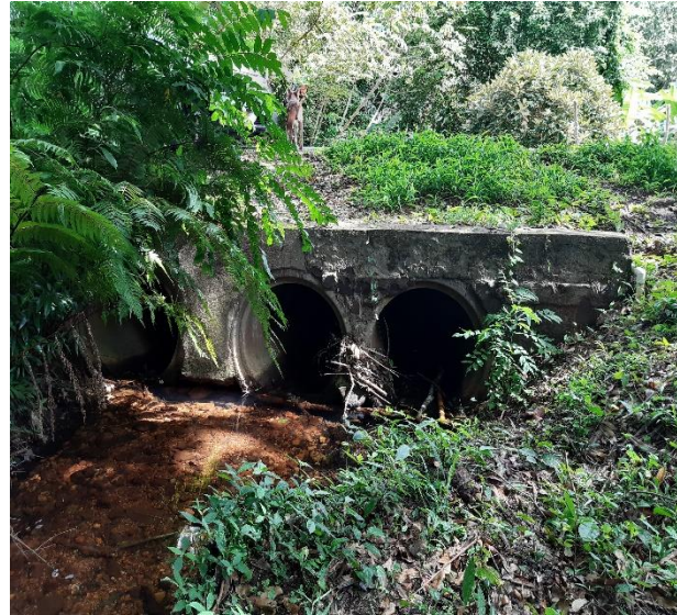
Der. Esta es la alcantarilla pluvial que permite el paso vehicular por la carretera a Punta Chame.
