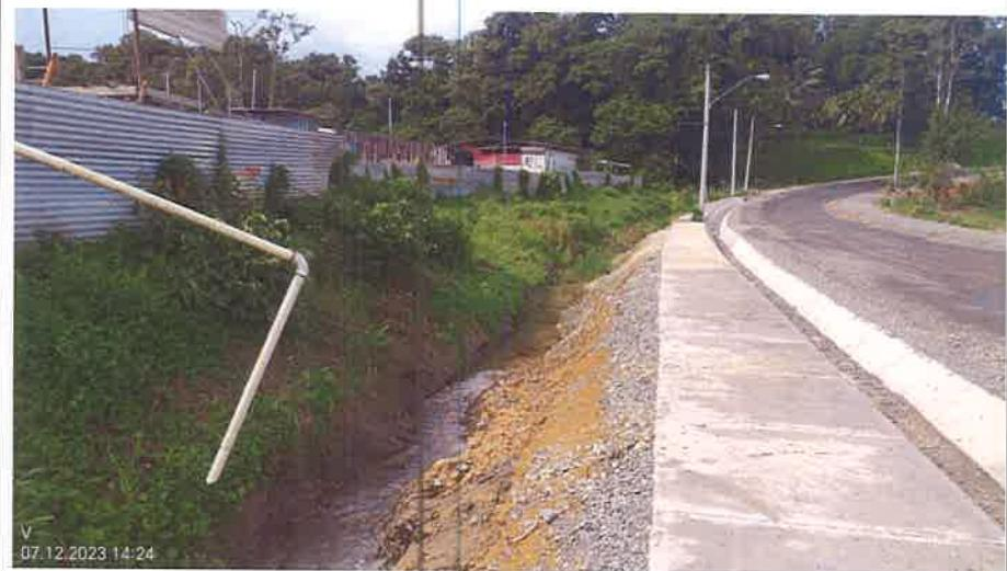
Cajon construido por la empresa INNINCO a lo largo de la carretera hacia Boca del Drago, y por donde drena el agua de la quebrada hacia humedal. Despues del cajón, se adicionan las aguas pluviales del proyecto urbanístico.
