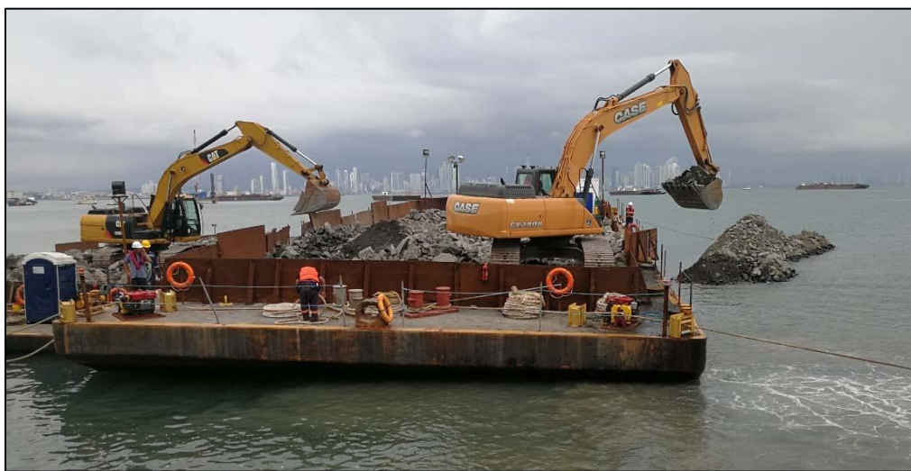
Ilustración 8. Vertido de roca con barcazas
