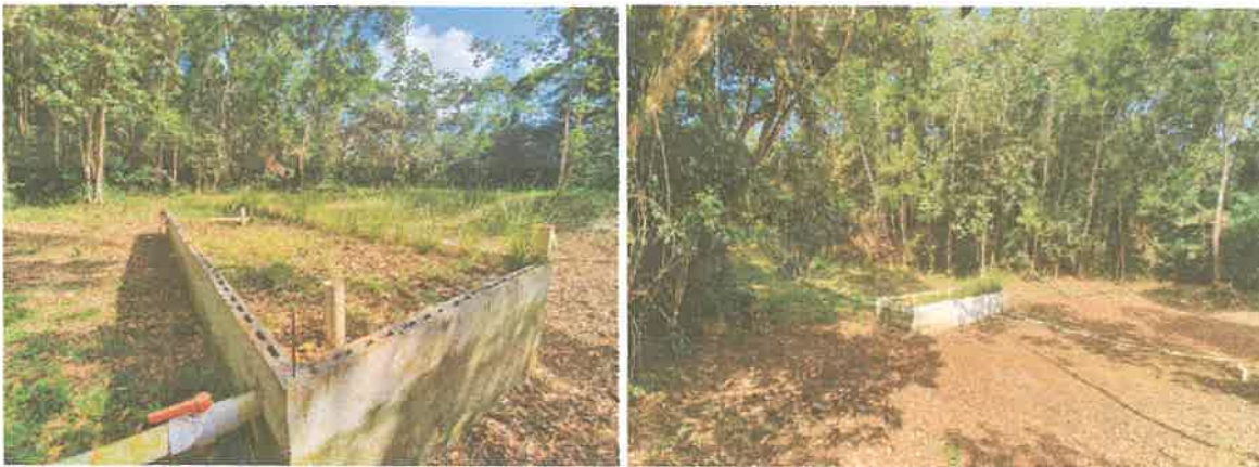
Fotografías No.1 y No.2: Tina facultativa construida para el tratamiento final de efluentes pretratados en tina de oxidación.
