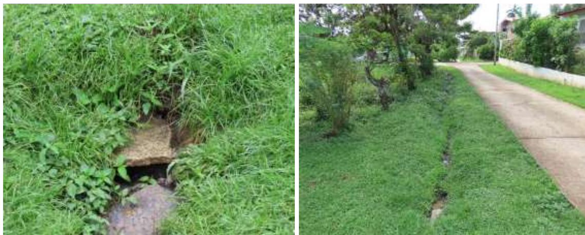
Imágenes 9 y 10. Descarga de aguas servidas
