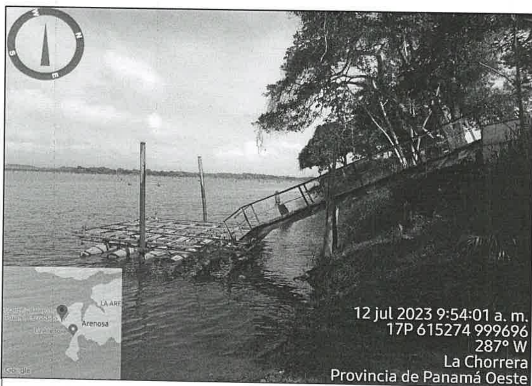
Imagen 3. Muelle que será remplazado por uno nuevo flotante para pequeñas embarcaciones, a orillas del lago Gatún. El área mantiene un talúd de aproximadamente 3 o 4 metros de altura, que según el EsIA será estabilizado con un muro de contención de tablaestacas, como alternativa para el control de la erosión y sedimentación.
