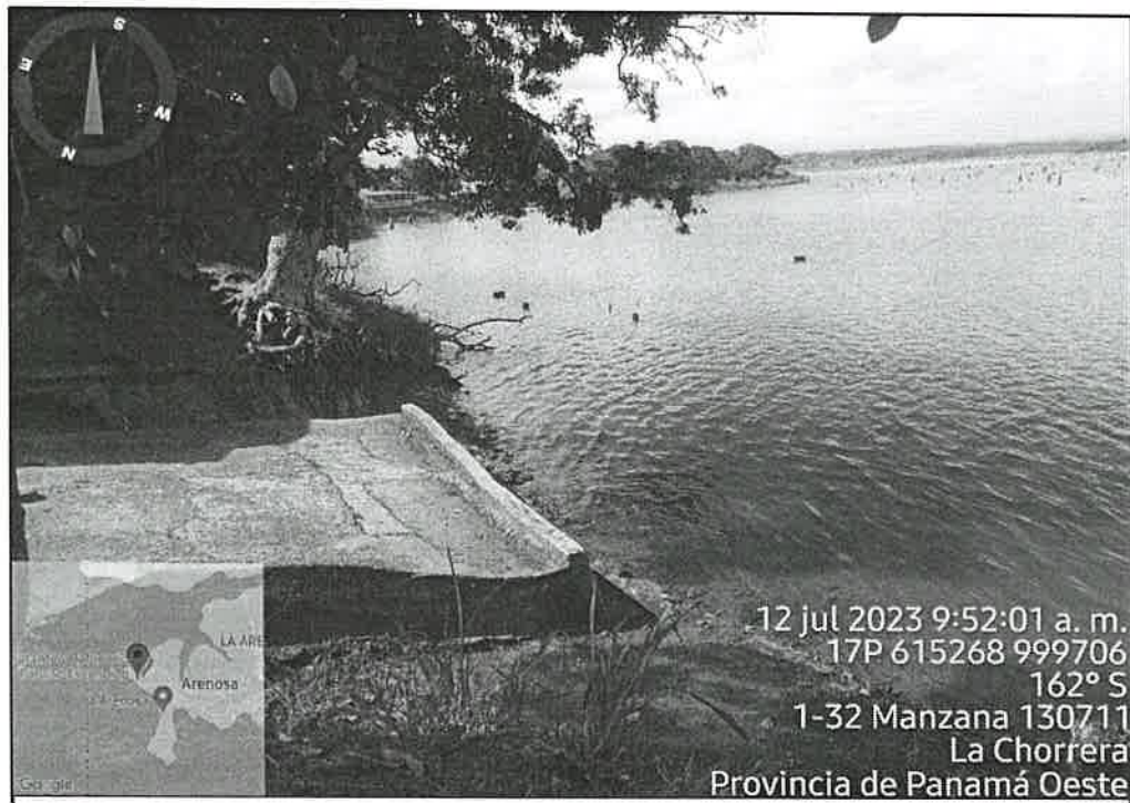
Imagen 5. Rampa de acceso existente de embarque y desembarque de botes y lanchas, que según el EsIA será extendida, la cual se le construirá la losa de concreto, igual manera se construirán cunetas abiertas de concreto para el manejo de las aguas pluviales que descargaran en el lago.
