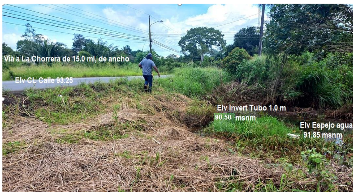
Foto No 5. 16. Salida de las aguas de escorrentía de la mini cuenca que en el área de influencia del proyecto Villas de Ensueño. Este es un punto crítico, los escombros de maleza, se atascan en la boca del tubo de 1.0 metro de diámetro, provocando inundaciones aguas arriba
