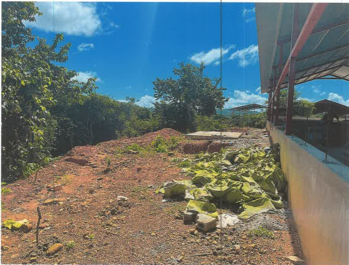
Foto N°4: Se observan residuos de construcción (sacos de cementos) que no han sido sometidos a disposición final.
