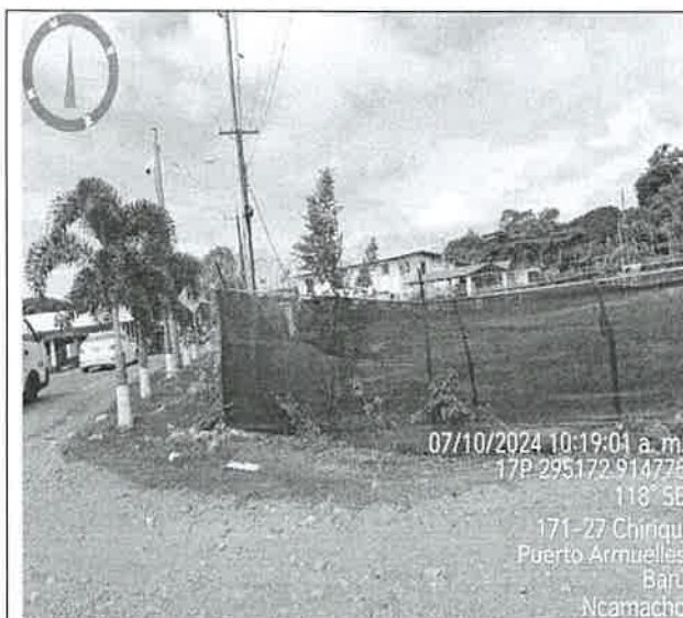
Foto N°1. Vista frontal del polígono en la colindancia con la Ave. de Las Arenas.
