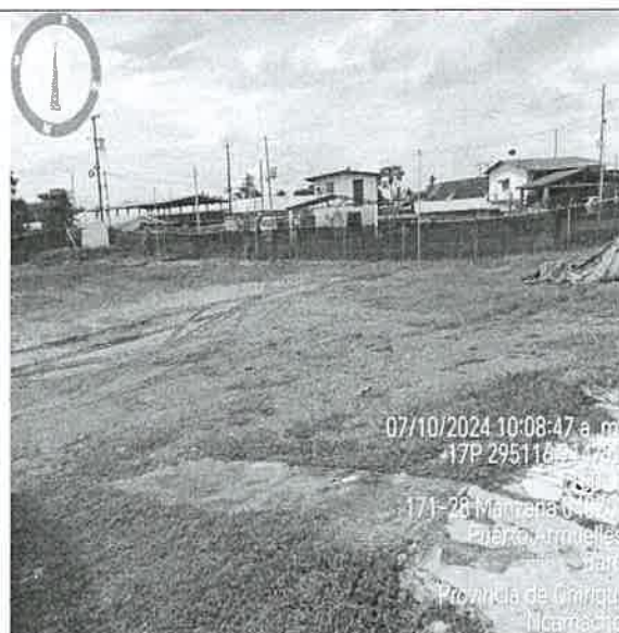
Foto N°4. Vista del sitio donde se colocarán las vigas para las infraestructuras
