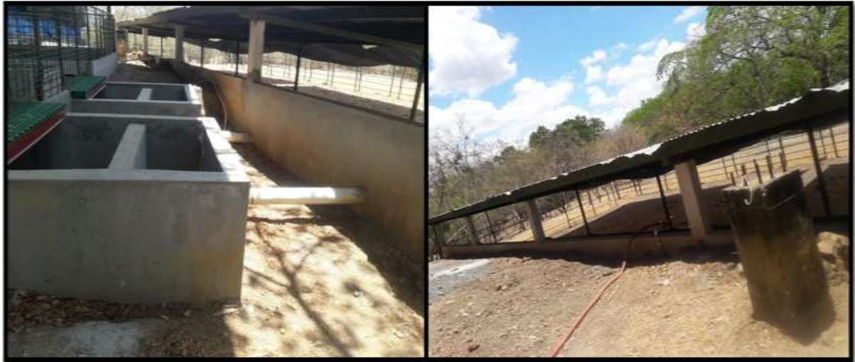
Foto 3. Manhole y separador de sólidos.
