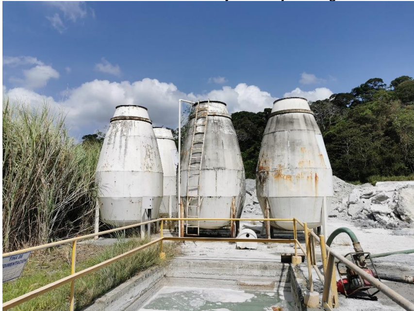
Foto N° 6. Área de tinas de sedimentación y reciclaje de agua.
