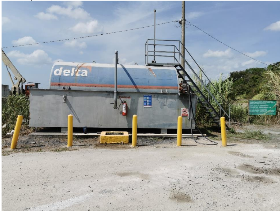
Foto N° 7. Tanque aéreo de almacenamiento de combustible
