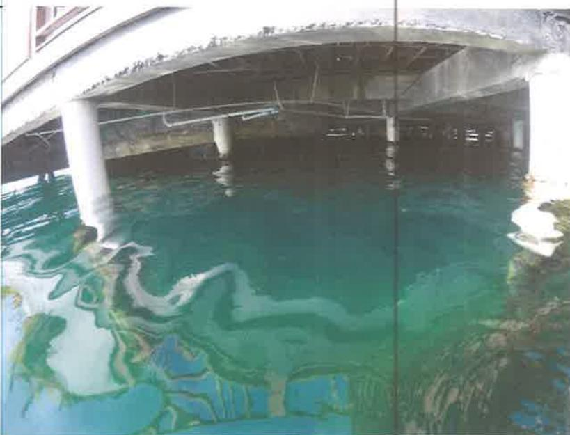
**Figura 5.** Reforzamiento de las bases, donde se aprecian los pilotes de P.V.C. de 10 pulgadas de diámetro rellenos de hormigón y reforzados con acero. (WGS84/UTM zona 17N 363850.51 m E, 1032507.45 m N)
