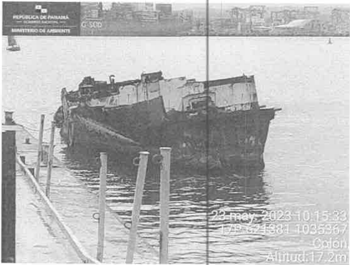
Foto No.7. Embarcación encallada que se encuentra dentro de la zona de construcción del muelle y que será desguazado.
