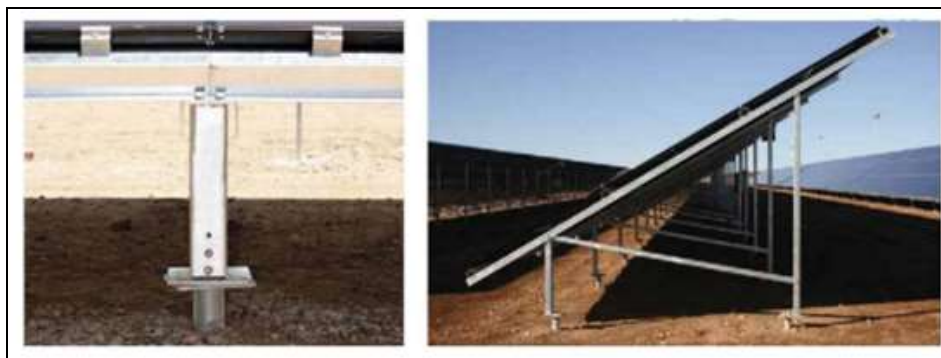
Ilustración 14 Aplicación típica del método de anclaje de la estructura al suelo.
