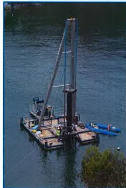
Fig. 1 Equipo para hincado de Pilotes.
