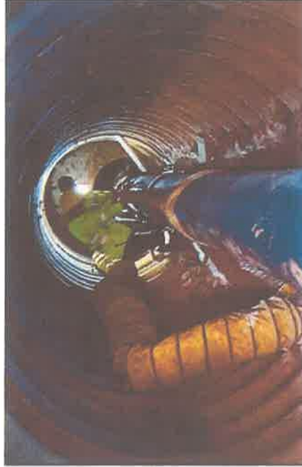
Detalles de Colocación de Tuberías de Hierro Dúctil:
