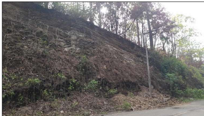
Ilustración 43 Talud 117+790- Costado izquierdo - acumulación de material desprendido
