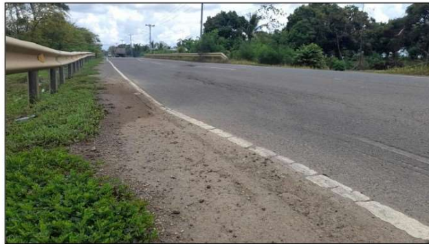
Ilustración 53 Punto K184+480 – Fisuras longitudinales- Carril derecho
