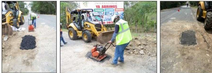
Ilustración 8. Colocación y compactación de asfalto frío.
