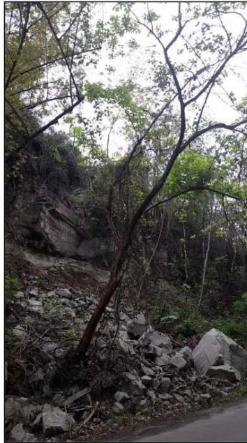
Ilustración 24 Caída de rocas Talud 88+800 - Costado izquierdo
