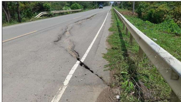
Ilustración 50 Fisura en medialuna - Punto K184+000
