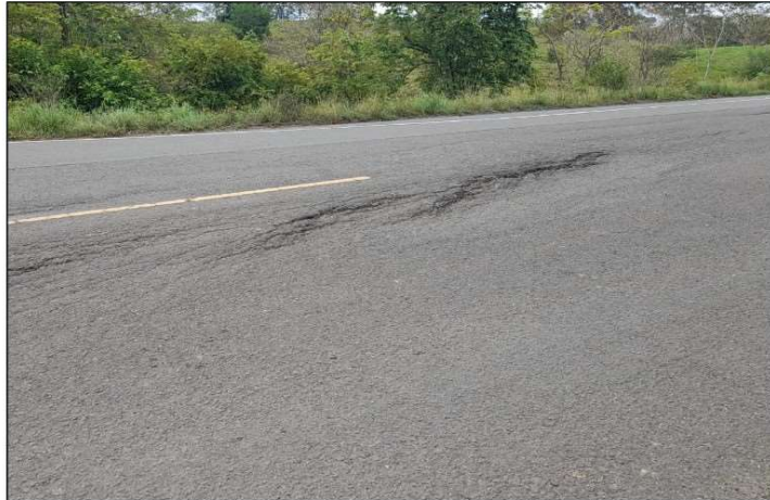
Ilustración 60 Punto 185+080 - Fisuras y desnivel mitad de calzada
