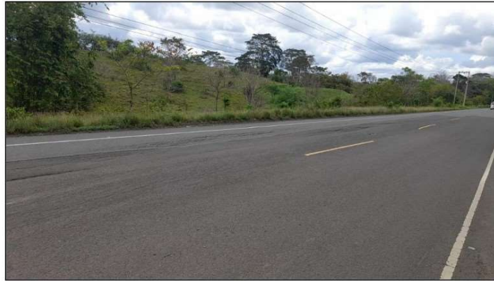
Ilustración 60 Punto 185+080 - Fisuras y desnivel mitad de calzada
