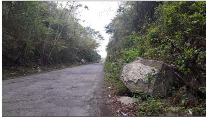
Ilustración 25 Caída de rocas Talud 88+800 - Costado derecho
