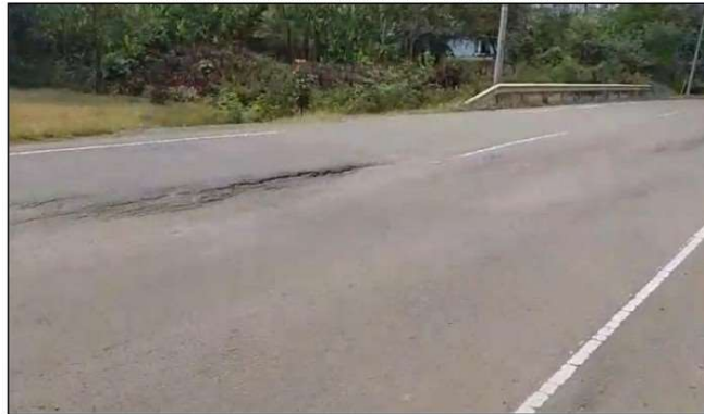
Ilustración 54 Punto K184+480 – Desnivel entre carriles
