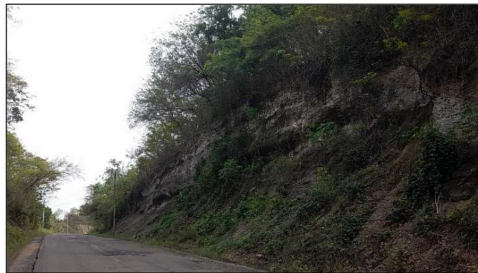
Ilustración 43 Talud 117+790- Costado izquierdo - acumulación de material desprendido
