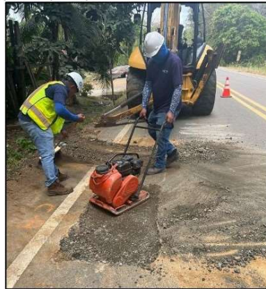
Ilustración 8. Colocación y compactación de asfalto frío.
