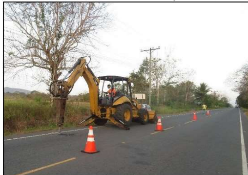
Ilustración 2. Retroexcavadora con martillo hidráulico para corte de losa o pavimento
