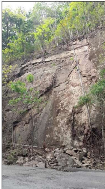
Ilustración 47 Talud 118+850 - Costado izquierdo – Caída de rocas
