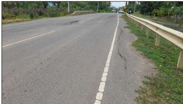
Ilustración 53 Punto K184+480 – Fisuras longitudinales- Carril derecho
