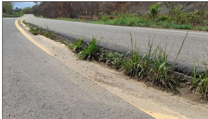
Ilustración 69 Punto 271+780 – Desnivel Carril Derecho
