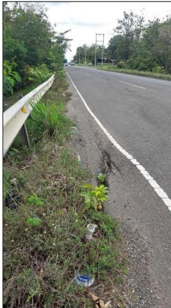
Ilustración 58 Punto 185+080 - Propagación de fisuras en profundidad
