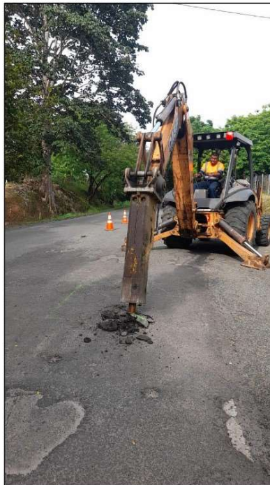
Figura 3 Ejecución calicatas sobre calzada - Corte de carpeta asfáltica
