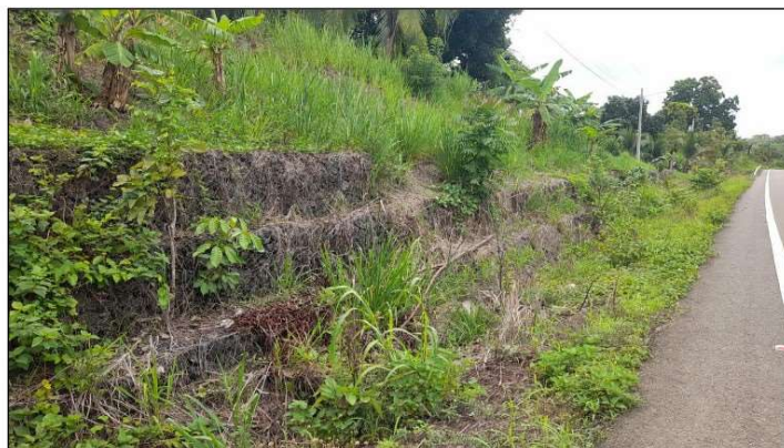
Ilustración 65 Talud 239+720 - Muro Gavión existente
