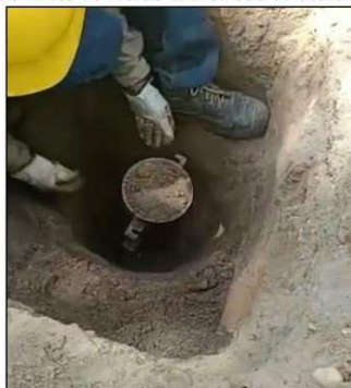
Ilustración 5 Hinca de molde CBR en suelo natural en calicata
