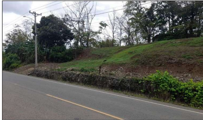
Ilustración 55 Talud 184+660 - Muro gavión existente – Costado izquierdo
