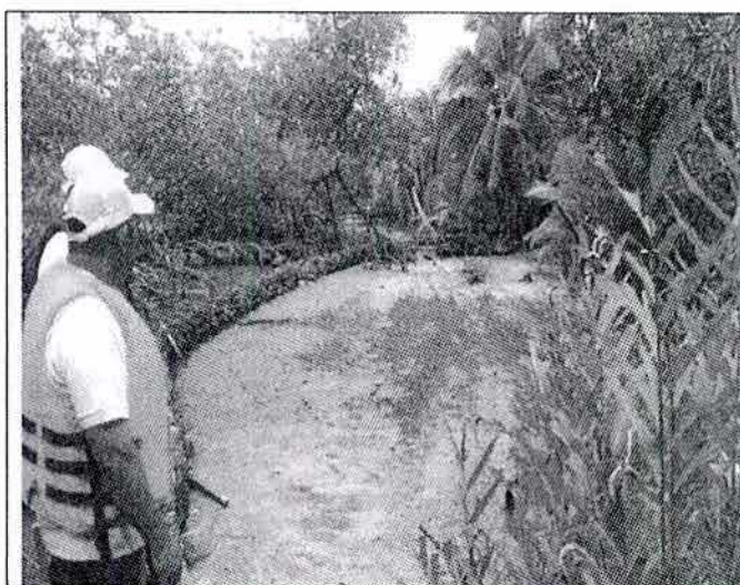
FOTO 1. Muro de enrocado sobre la ribera de mar, que obstaculiza la entrada de la marea.
