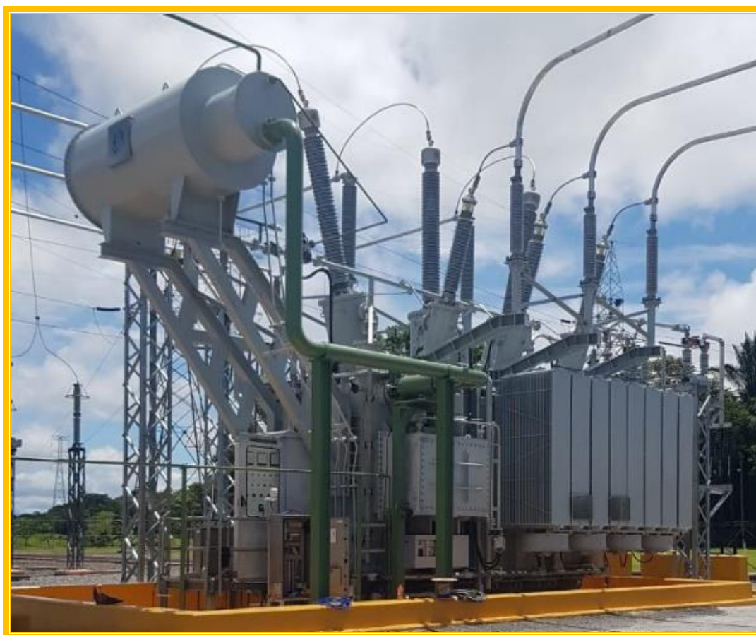
Fuente: Promotor 2024 – Ilustración de un transformador de 120MVA.
