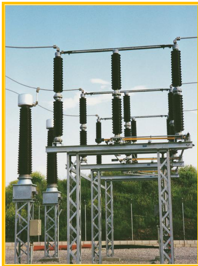
Fuente: Promotor 2024 – Ilustración de un seccionador de potencia (barras superiores) con puesta a tierra (barra amarilla)
