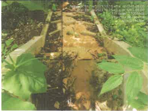
Foto 17. Canales pluviales contruidos afluente 2.
