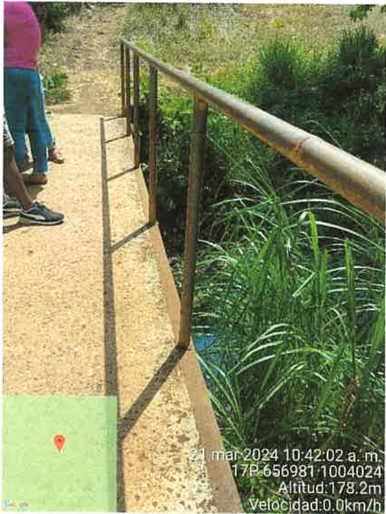
FOTO 3. Puente sobre Quebrada Manteca. La conducción de la tubería se hará a través de un paso aéreo.
