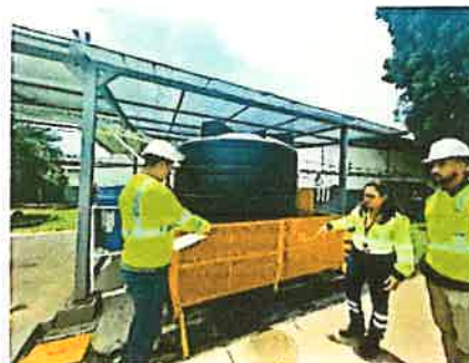
Tanque de almacenamiento de agua cruda actual- 20,000 gal
