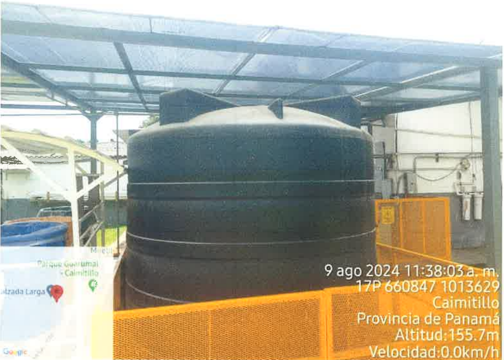
Foto. 2. Se observa el Tanque de almacenamiento de Agua tratada de 10 m 3 , dentro del radio del proyecto.
