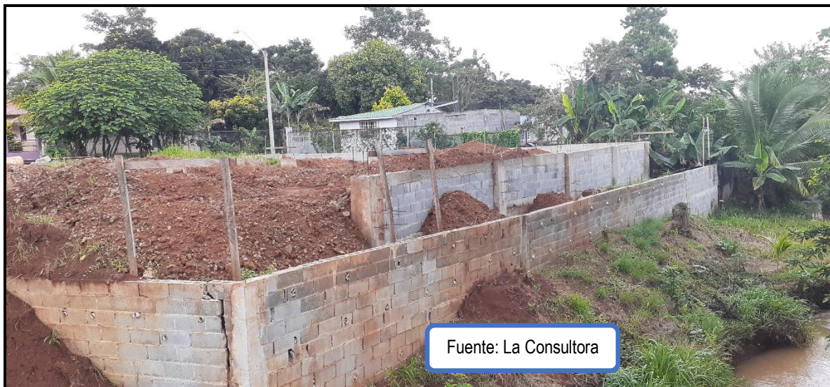
Ilustración 17 Esta imagen corresponde a la vista del proyecto desde la carretera, se observa que ya existe un muro destinado para evitar la sedimentación y posible afectación a la quebrada existente en el lugar.
