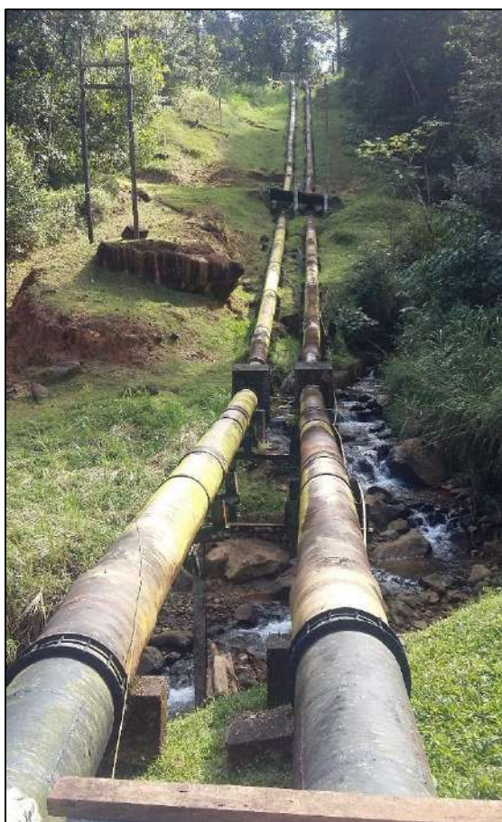
Foto No. 7. Línea de conducción del agua hacia la casa de máquinas.
