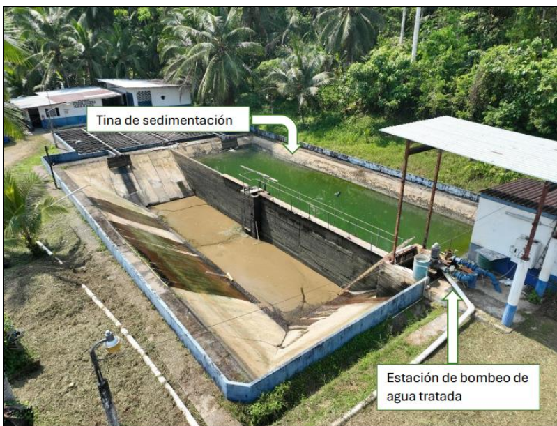
Figura 36. Tinas de sedimentación y Estación de bombeo de agua tratada.
