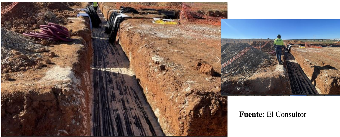
Figura 4.11. Apertura de Zanjas y colocación de cables
