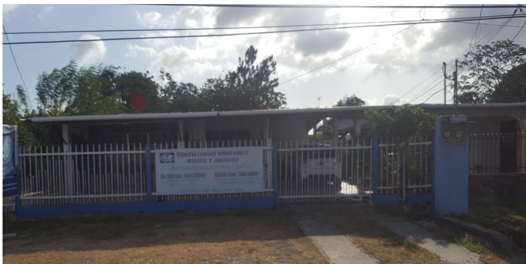
Foto que muestra la vivienda existente que actualmente es utilizada como clínica médica la cual será demolida para dar paso al nuevo local comercial.
