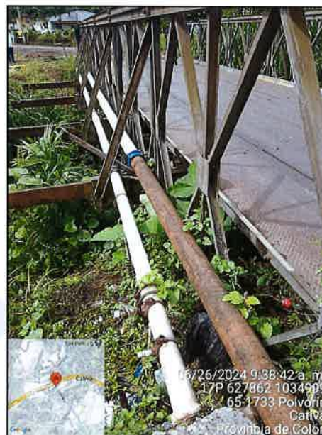
Ilustración N° 2 Tuberías sobre el Puente El Polvorín.
