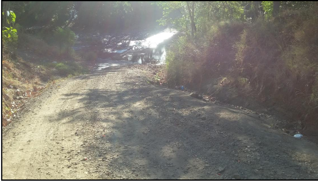
Foto N° 5: Camino existente de acceso puente modular a instalar; calzada de material selecto.
