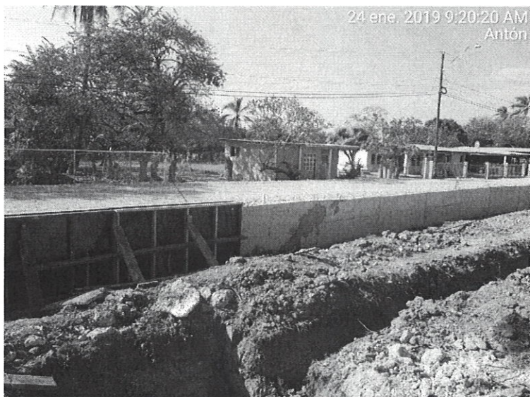
Fig. 1: Se observa el muro perimetral en construcción, en referencia con la rasante de la calle existente.
