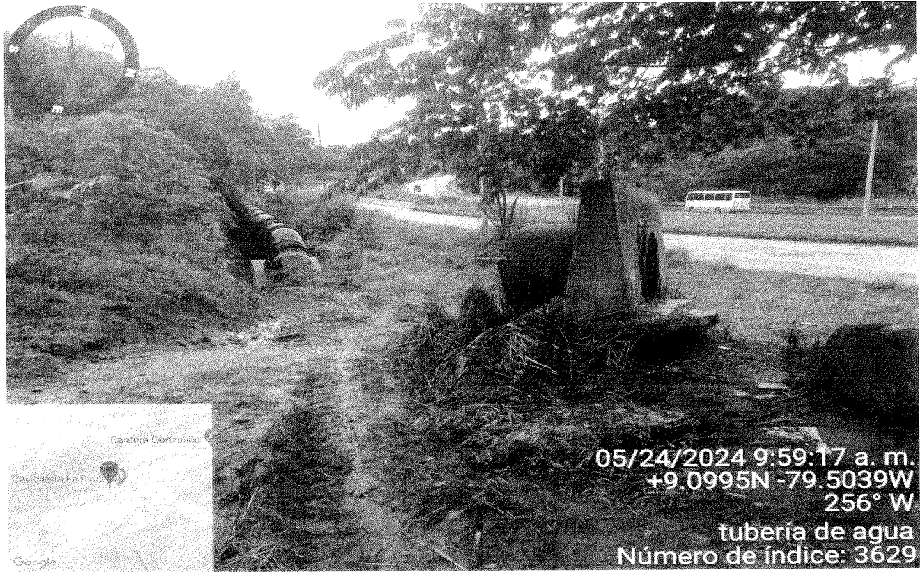
Revisión de los planos no aparece la tubería de Agua que se observó en campo
