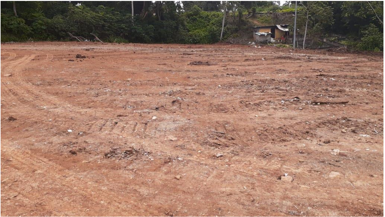
Material compactado y áreas futuras para relleno
