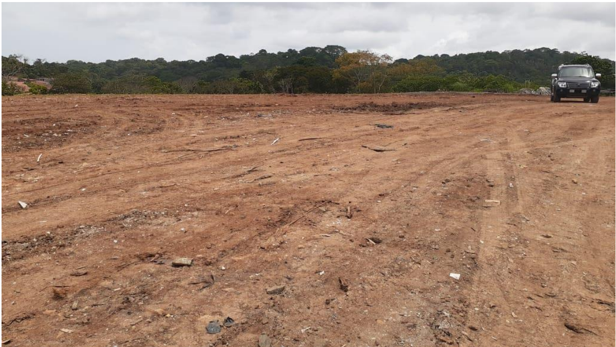
Material debidamente compactado
