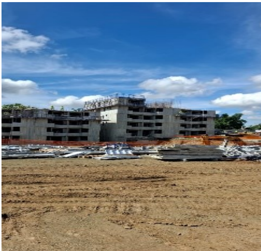
Foto No. 5.3.4-1. Etapa 1 en construcción.
