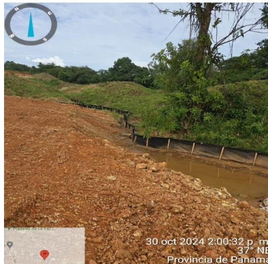
Imagen No. 1 conformación final de taludes
