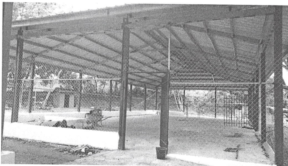
Fig. No. 3: El proyecto presenta avance en la construcción de cimientos, instalación de columnas y vigas, techo y piso.
