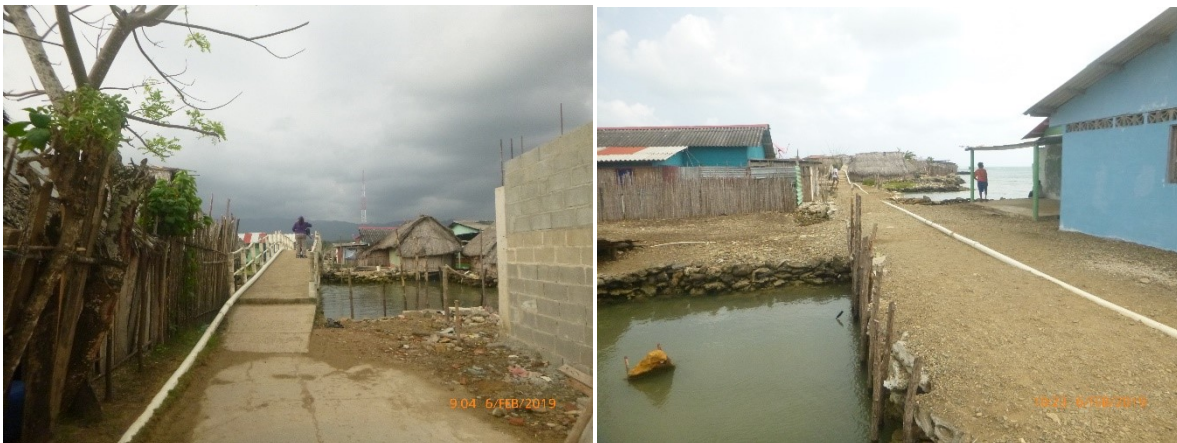
Foto 16. Inicio del puente, ubicación en coordenadas UTM WGS84: 197393E, 989880. Foto 17. Puente colapsado y relleno con piedras coralinas y gravas del río.
