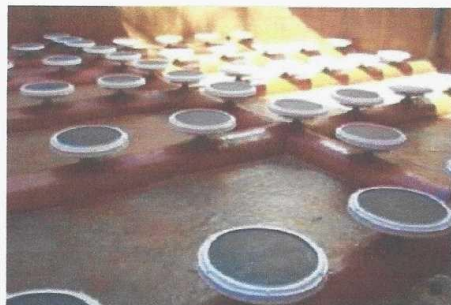
Imagen 3. Sistema de Difusión de Oxígeno mediante Membranas.
