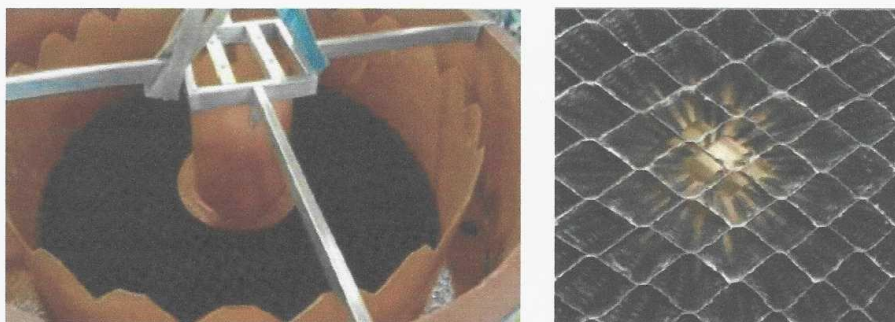
Imagen 3. Sedimentación de Alta Tasa mediante Placas Lamelares
