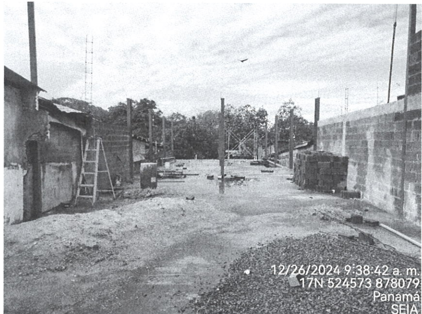
Foto 2. Otra vista del área del proyecto, se observa columnas de viga H y tubo cuadrado y materiales entre estos: arena y piedra.
